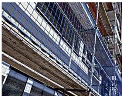
Für Seitenschutznetze und Netze in Dachfanggerüsten sind die EN 1263-1, die DIN EN 13374 sowie für die Montage die EN 1263-2 und die DGUV-I 201-023 maßgebend. Diese Netze werden als Schutznetzsystem U (Schutznetz in Tragkonstruktionen für vertikale Verwendung) bezeichnet. Bei Einsatz von Netzen kann auf den Zwischenholm verzichtet werden. Ringsum werden die Netze mit einem angekettelten Einfassseil versehen. Aus Polypropylen hochfest, ca. 5 mm, mit angeketteltem Einfassseil.
